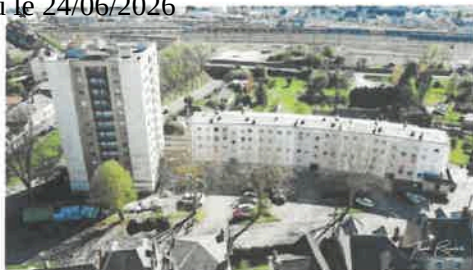
Résidence Gustave Flourens avec l'ancienne tour déconstruite
