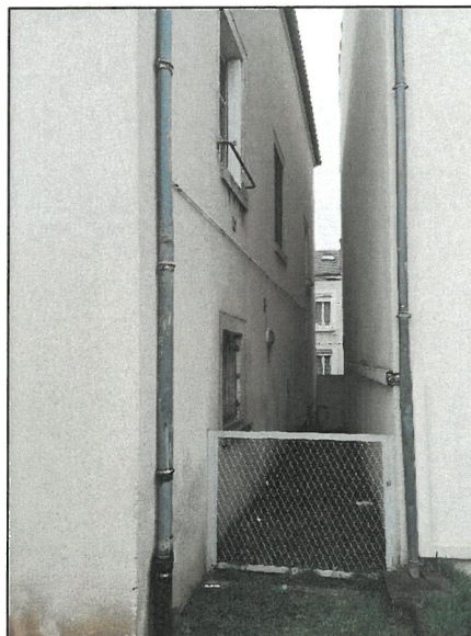
Photo n°8 : Passage pour aller au sous sol (chaufferie). Limite séparative avec l'immeuble voisin
