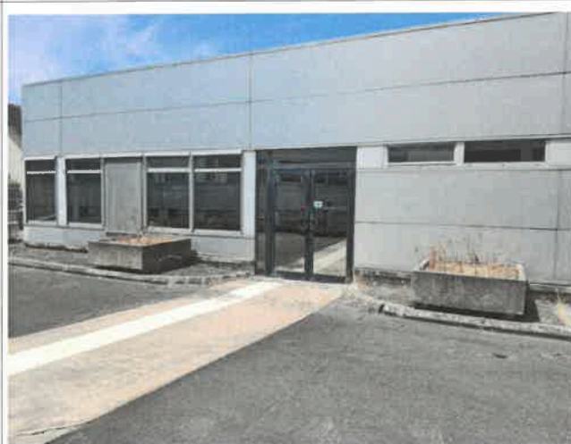
Façade avant du bâtiment
