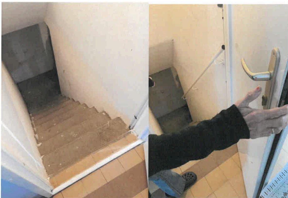
Installation d'une main courante dans l'escalier
