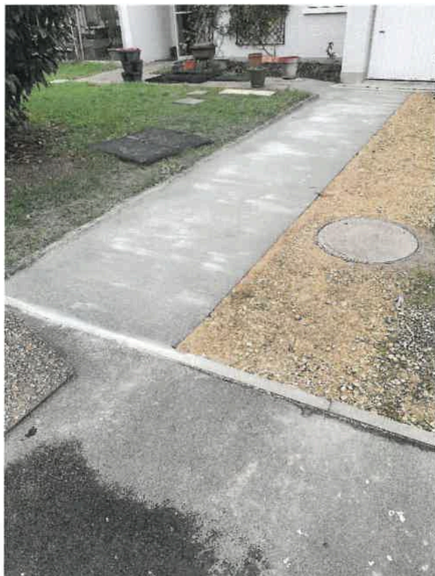
Réalisation d'un chemin extérieur d'accessibilité au logement
