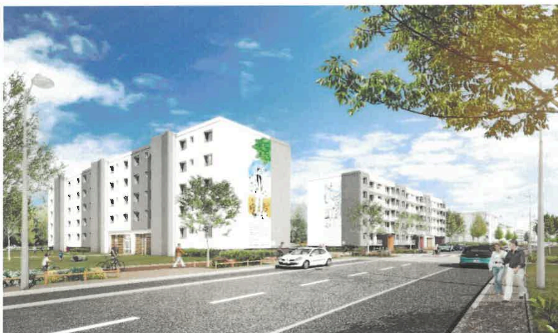
Réhabilitation Rue Paul Verlaine - 116 logements à Bourges - Atelier Carré d'Arche
